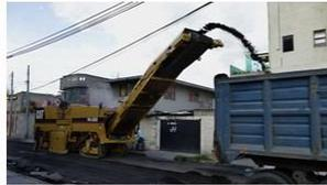
Figura 4. Frezado de Pavimento.
